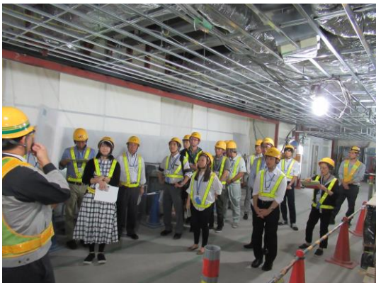
東京駅構内工事箇所にて
